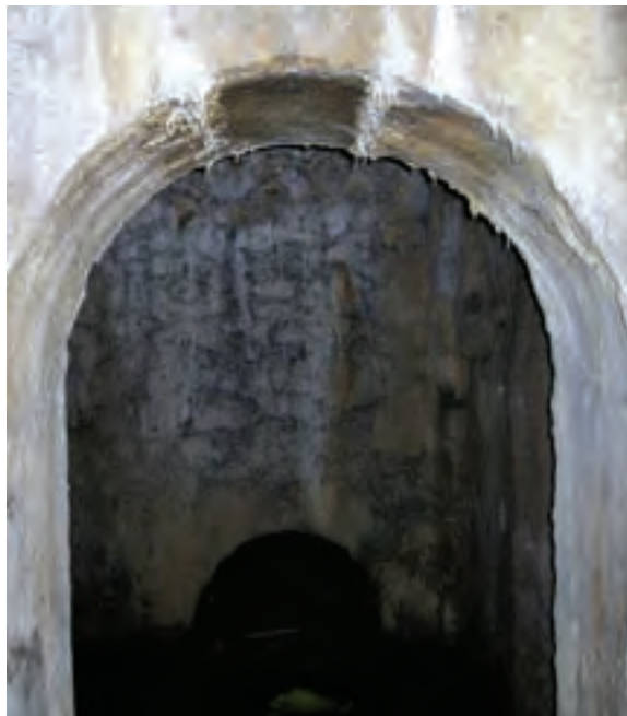
/ Tunel hidraulikoa. ▲ / Túnel hidráulico.
